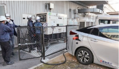
PHV給電+自家発電訓練
