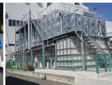
豊田工場 緊急貯留槽
