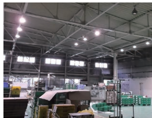
高天井の水銀灯をLED化
