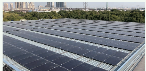
TRCW(中国)に導入したメガソーラー(2017年度設置)
