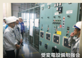
受変電設備勉強会
