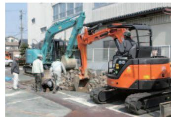
▲汚染土壌の掘削除去作業
