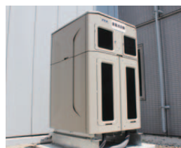
▲蓄電池システム
