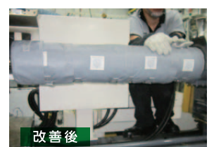
▲断熱ジャケット巻付け後
