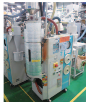
▲TRT (タイ) で実施した材料乾燥機の断熱施工
