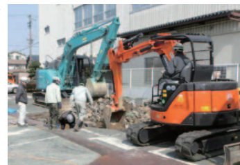
▲汚染土壌の掘削除去作業
