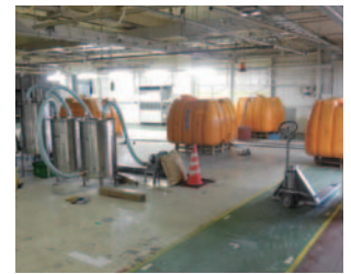
▲浄化対策を試行(旧西枇杷島工場)
