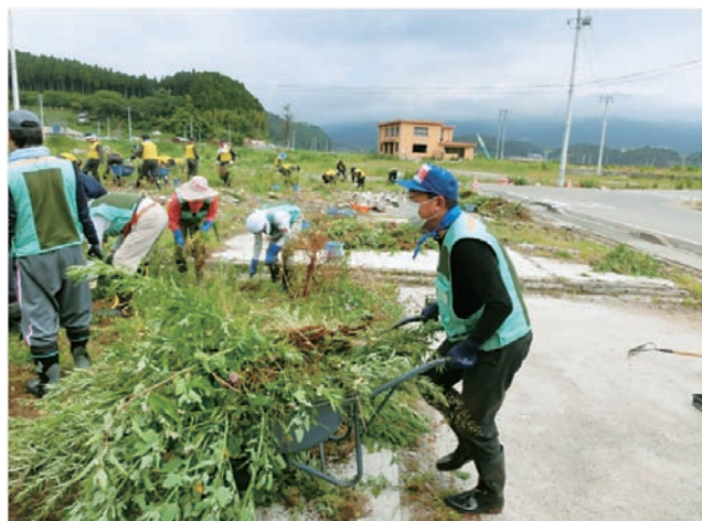
▲宅地跡の整備(陸前高田市)
