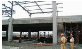
▲海外建設現場の安全点検
