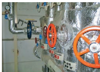
▲バルブネックの断熱による放熱ロス低減の事例
