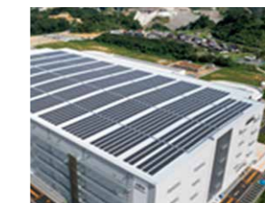
物流倉庫 屋上太陽光
