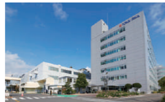
●本社・本社工場 Head Office & Plant 主要生産品目/レバーコンビネーションスイッチ・ パワーウィンドウスイッチ・プッシュスタートスイ ッチ 他各種スイッチ・エレクトロニクス製品・ミラー Main Products: Multi-Function Switch, Power Window Switches, Push Start Switches various Automotive Switches, Electronic Parts, and Mirrors.
