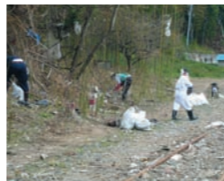
▲がれきの撤去作業
