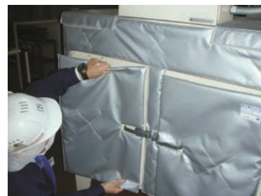
▲材料乾燥機へ断熱材を取り付ける様子
