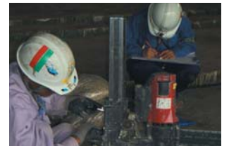
旧めっき設備撤去作業
