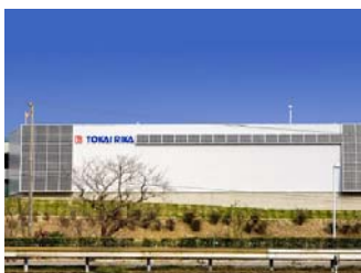
▲音羽工場立体駐車場
