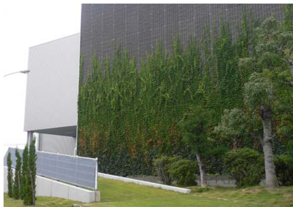
▲新電波実験棟西側外壁
